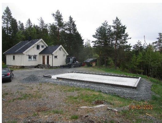
Garasjetomt med ferdig såle og ringmur
